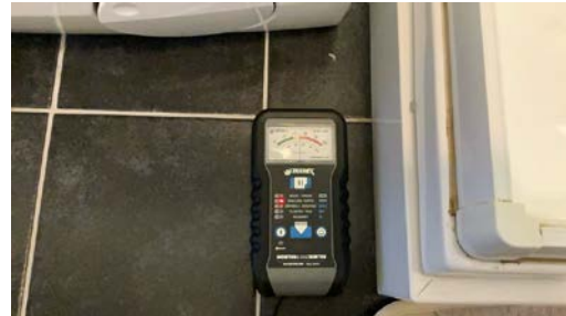
Fuktsøk på gulv/vegg i dusjonen viser ingen unormale verdier. Det er målt referansepunkter andre steder i rommet enn i dusjonen.
