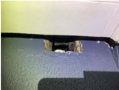
Åpning/hull i pipeløp.
