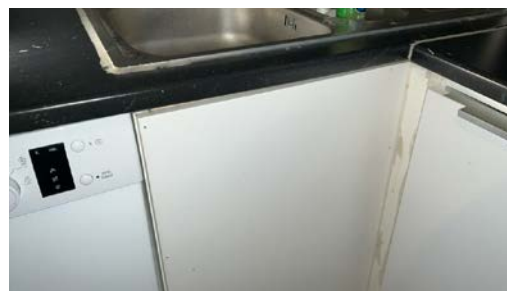
Kjøkkenfront under kjøkkenkum er spikret igjen.
