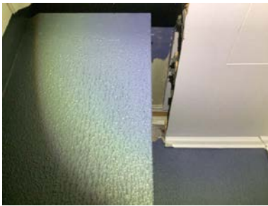
Åpen nedforet himling mot pipe, isolasjon er ikke tildekket.
