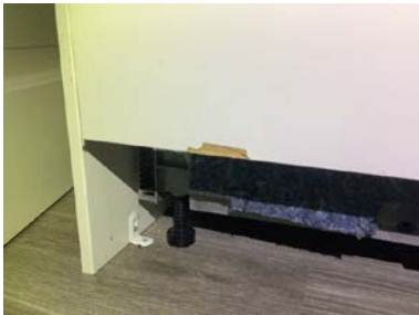
Skade på front oppvaskmaskin.
