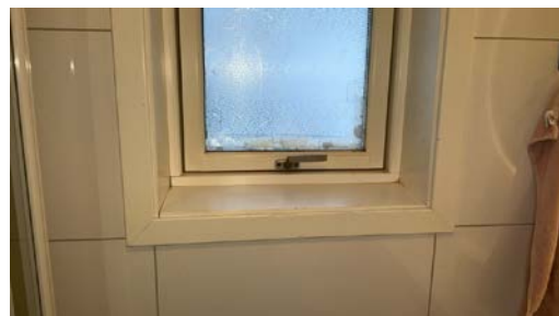
Det er observert ufagmessig utførelse på arbeid med overflater på rommet. Vindu plassert i våtsone.
