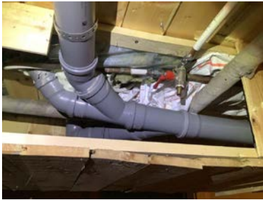
Avløpsrør under våtrom 1. etasje, synlig fra kjeller.
