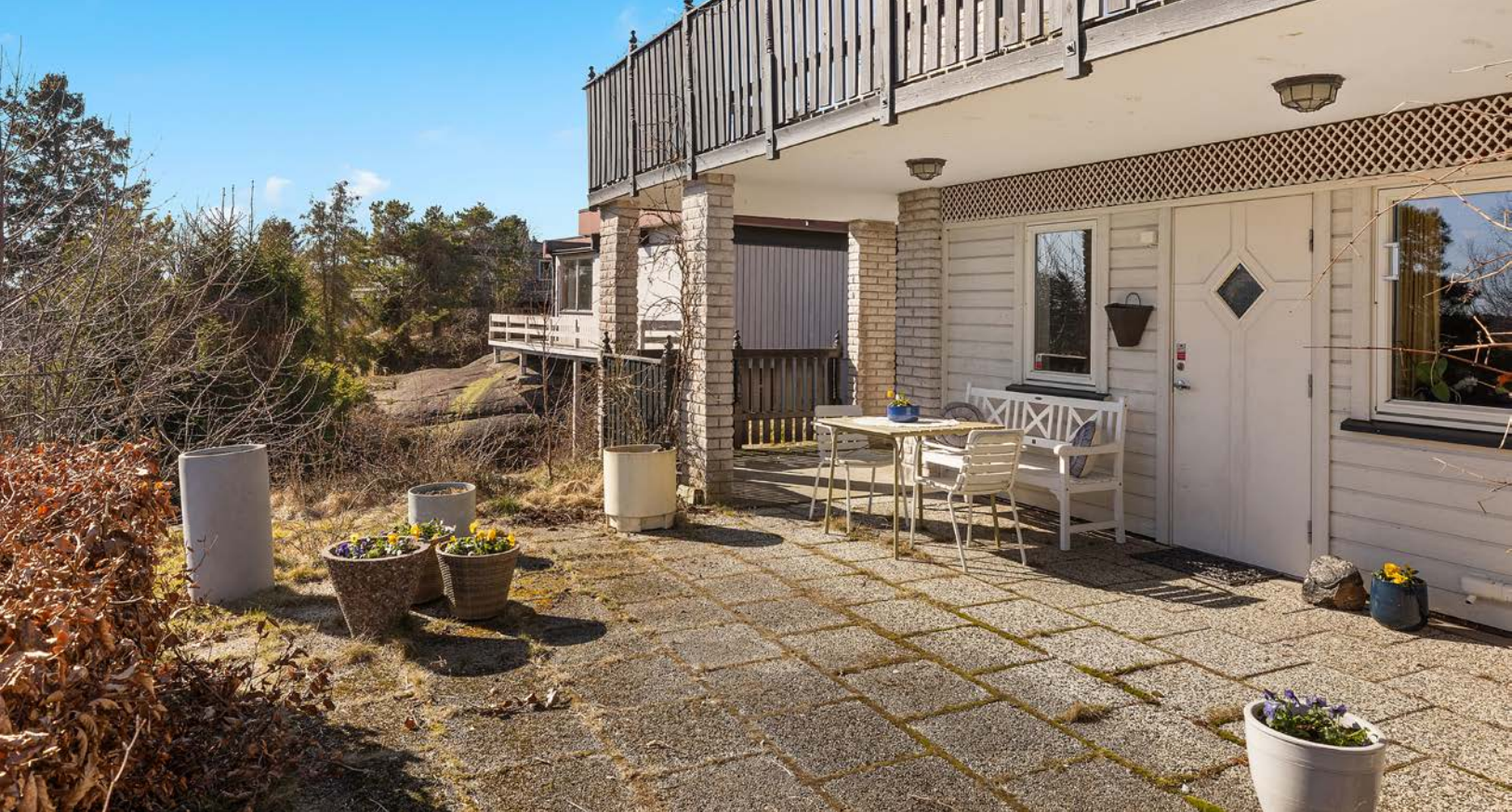
Det er vannbåren gulvvarme i flere rom i underetasje samt bad i hovedetasje
