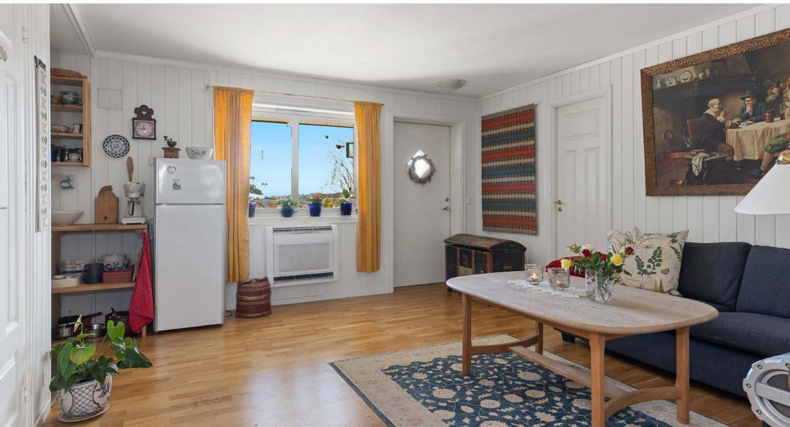
Det er montert luft/luft varmepumper i hovedetasje og i leilighet i underetasje i 2024
