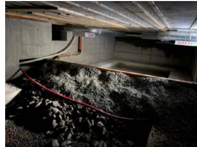
Utsparinger i grunnen er etablert slik at overflatevann kan dreneres ut gjennom grunnen.
