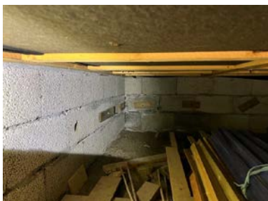
Kryprom under tilbygd stue på hoveddel
