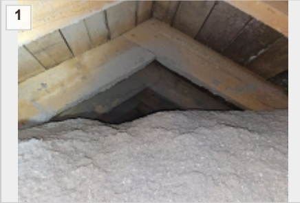
Etterisolert himling.
