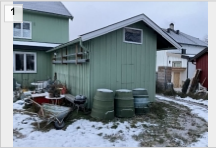
Uisolert lagerrom bak hoveddelen.
