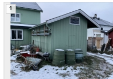
Uisolert lagerrom bak hoveddelen.
