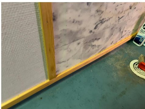
Organisk materiale er benyttet i våtsone
