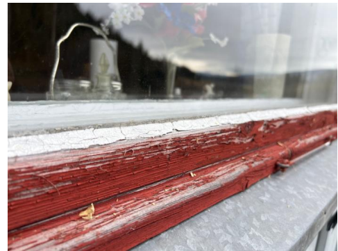
Vinduer er preget av elde og slitasje
