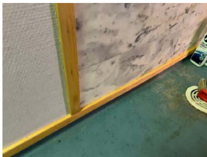
Organisk materiale er benyttet i våtsone
