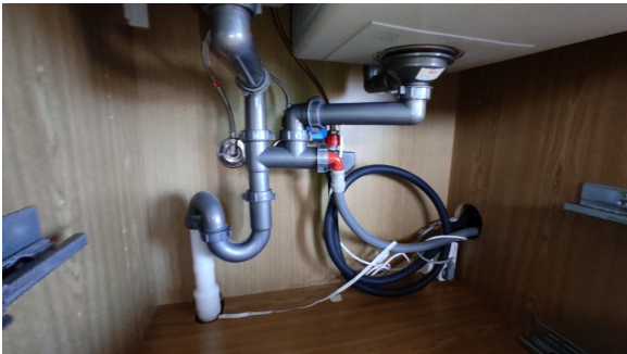
Kontroll av røropplegg.
