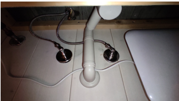
Kontroll av røropplegg.
