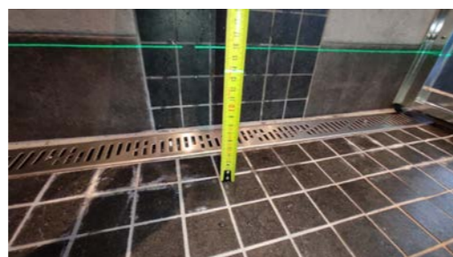
Kontroll av fallforhold.
