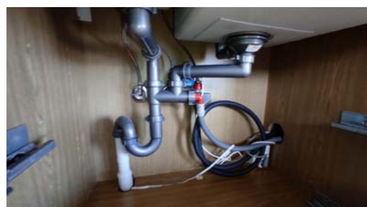
Kontroll av røropplegg.
