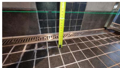
Kontroll av fallforhold.
