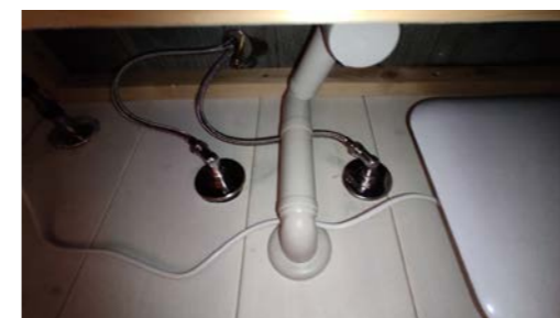
Kontroll av røropplegg.
