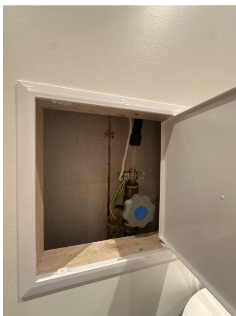
Viser vanninntak og hovedstoppekran i kasse på bad i kjeller.
