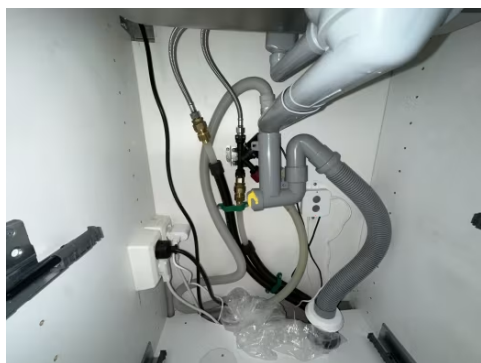
Viser vann og avløpsinstallasjoner under kum.
