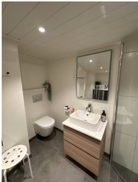
Viser baderomsinnredning og toalett med innebygget sisterner.
