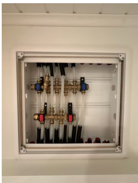
Viser vanninntak og hovedstoppekran i kasse på bad i kjeller.
