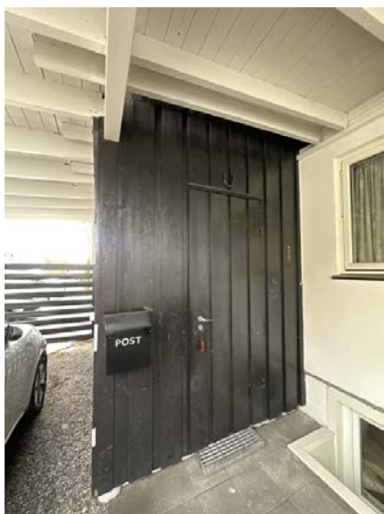
Viser utvendig bod.
