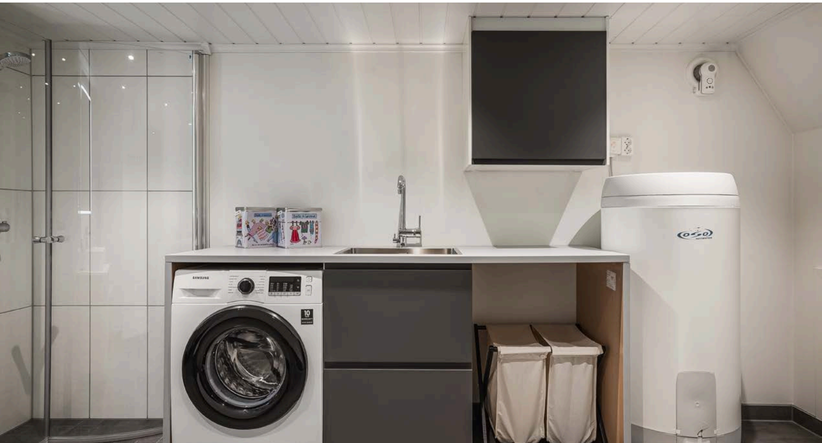
Praktisk vaskeromsinnredning med plass og opplegg for vaskemaskin.
