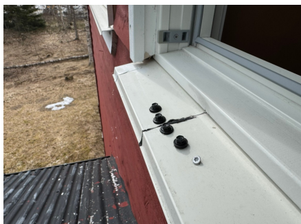
Ufagmessig utførelse av beslag under vinduet.
