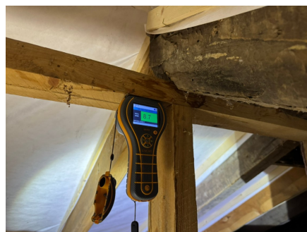
Fuktmåling i takkonstruksjonen viser ikke skadelige verdier.
