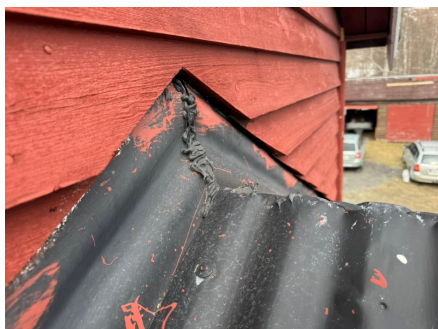
Eksempel på utvendig beslag.
