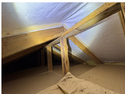
Undertak som er montert mellom sperrene.
