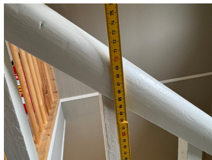
Rekkverkshøyden.
