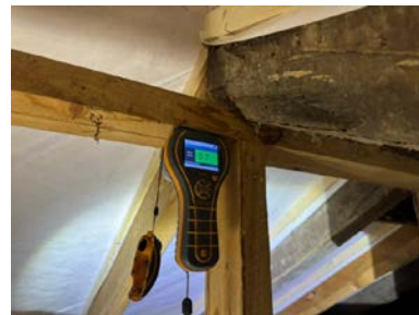
Fuktmåling i takkonstruksjonen viser ikke skadelige verdier.
