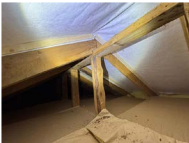
Undertak som er montert mellom sperrene.
