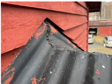
Eksempel på utvendig beslag.
