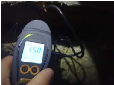
Ingen skadelig fukt ved måling i etasjeskille under bad.
