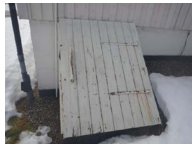
Luke til kjellernedgang må rengjøres og overflatebehandles.
