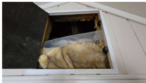
Luke til kaldloft er kun til inspeksjon fra luke (50x50 cm)
