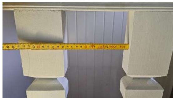
For store åpninger i rekkverk.
