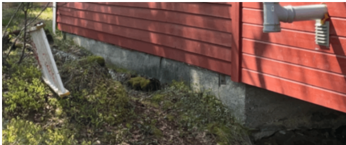
Utvendig grunnmur mot øst
