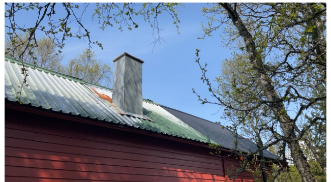
Takplater er skjøtet på taket med nye plater.
