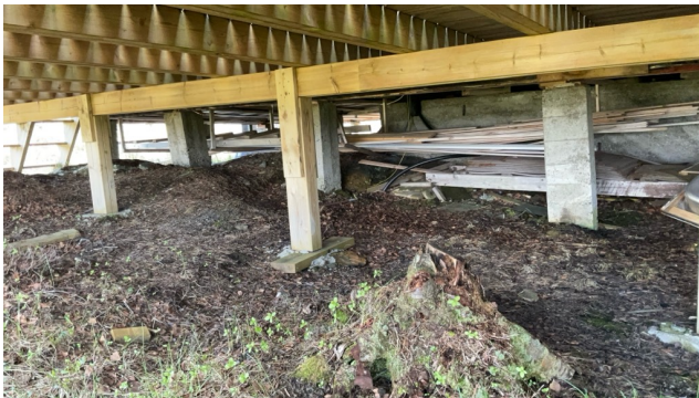
Trepilarer fundamentert på bakken.
