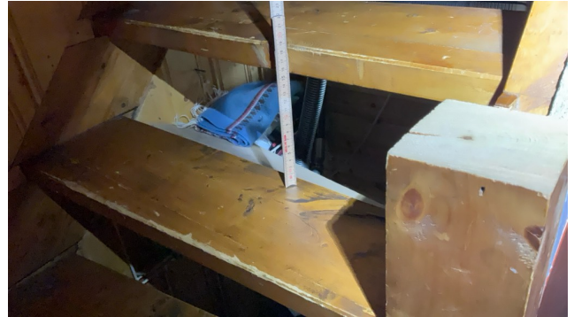
Åpninger mellom trinn i innvendig trapp er større enn dagens forskriftskrav.
