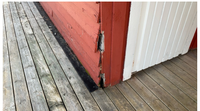
Råteskadet panel.
