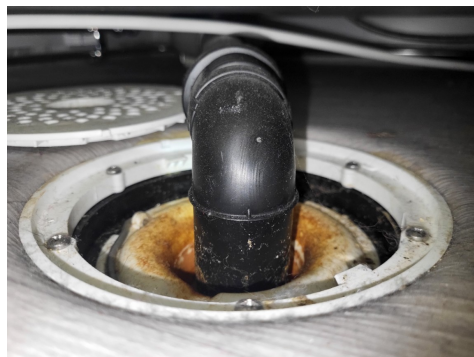
Sluk med synlig belegg som tettesjikt.
