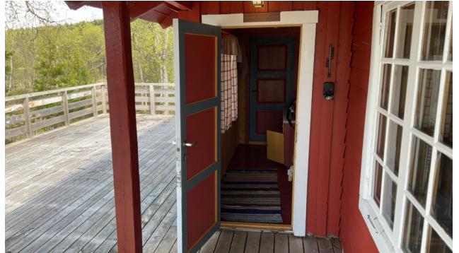
Uisolert ytterdør.
