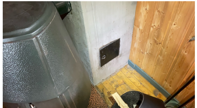
Ildfast plate mangler på gulvet under sotluke på pipe.
