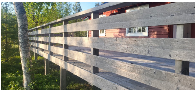
Ubehandlet rekkverk.
