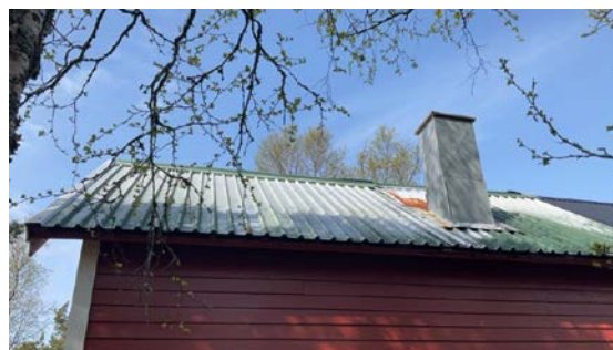
Eldre takplater på gammel del
