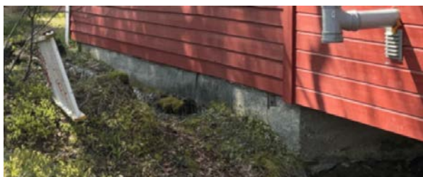
Utvendig grunnmur mot øst
