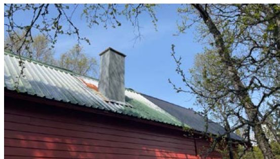
Takplater er skjøttet på taket med nye plater.
