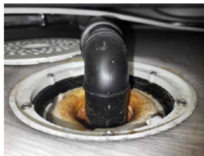
Sluk med synlig belegg som tettesjikt.
