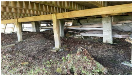
Trepilarer fundamentert på bakken.
