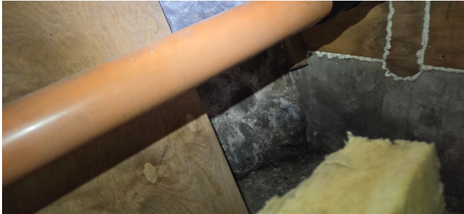
Fuktmerker grunnmur
