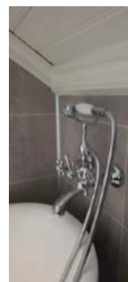
Ikke membran i skråtak over dusj i våt sone
