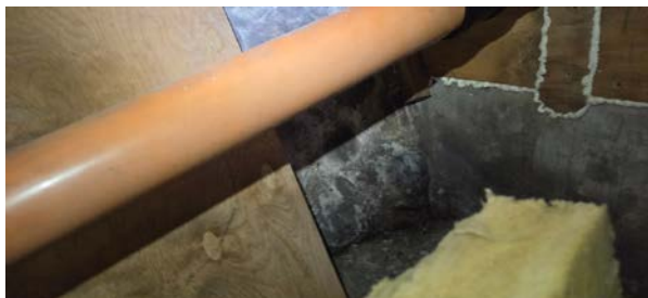
Fuktmerker grunnmur
