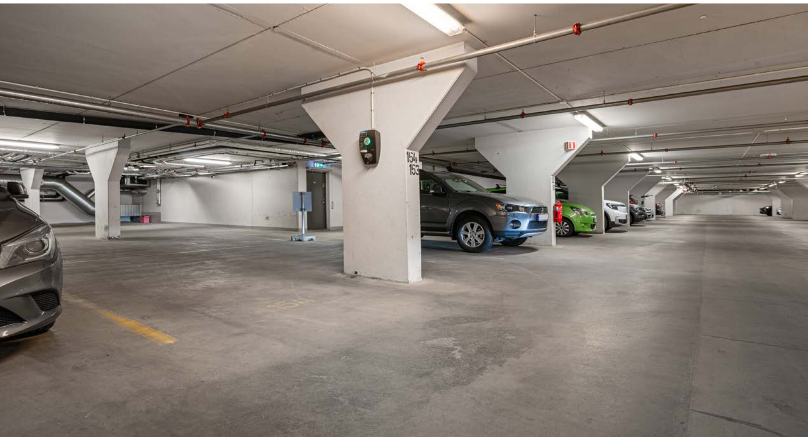
Det følger én garasje plass med elbil-lader i nabobygget.
