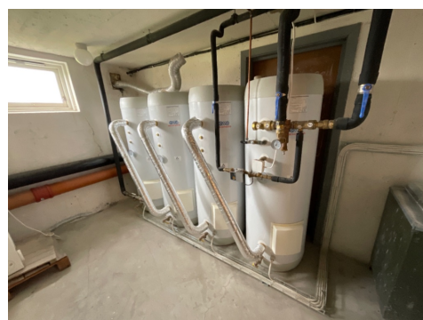
Sentral varmtvannsberedning
