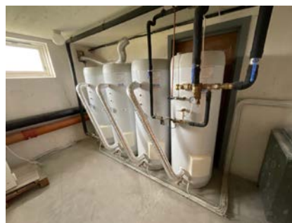
Sentral varmtvannsbereding
