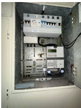
Sikringsskap med automatsikringer.
