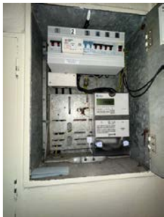
Sikringsskap med automatsikringer.
