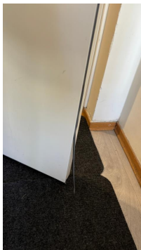
Klassifisert entredør m/løsnet gummlist
