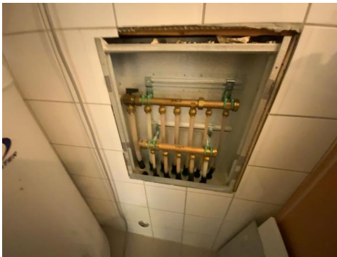
Besiktigelse av røropplegg.
