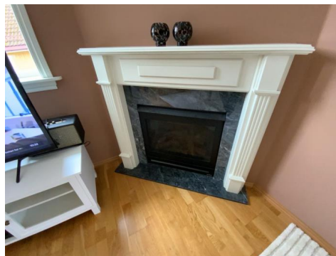
Besiktigelse av ildsted.
