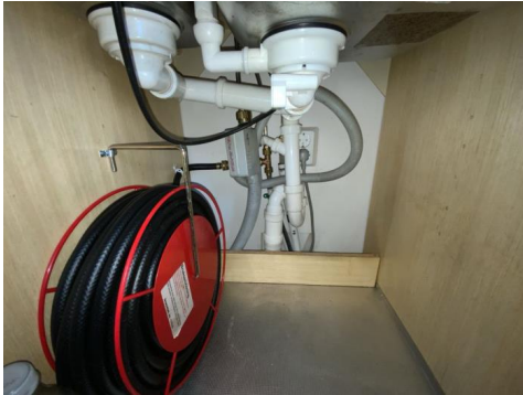
Besiktigelse av røropplegg.
