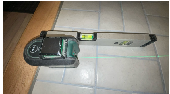
Fallforhold målt i retning sluk.
