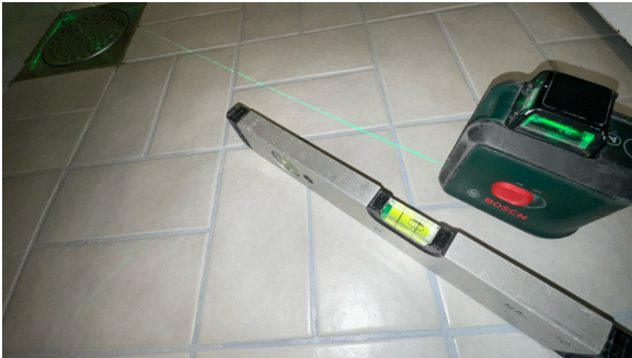
Fallforhold målt i retning sluk.
