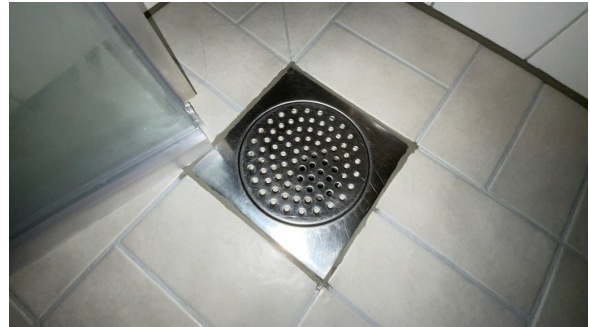
Nyere fuger rundt slukrist er lagt ved egeninnsats.
