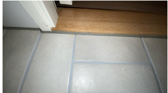
Overgang ved dørterskel.
