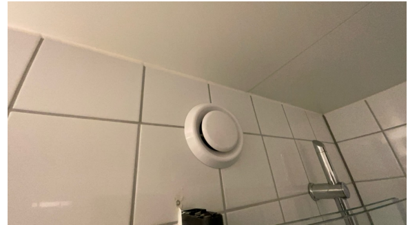
Avtrekkventil
