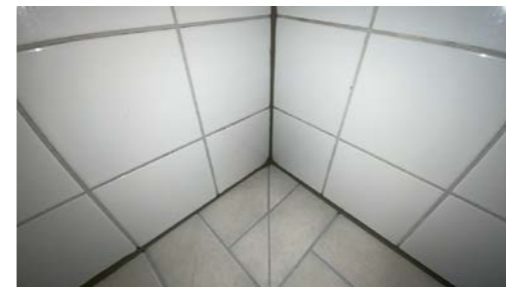
Nyere silikonfuger er lagt ved egeninnsats.
