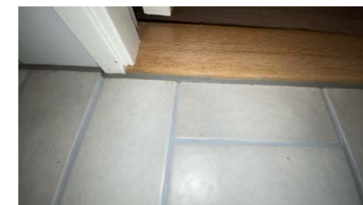
Overgang ved dørterskel.
