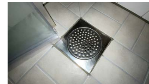
Nyere fuger rundt slukrist er lagt ved egeninnsats.
