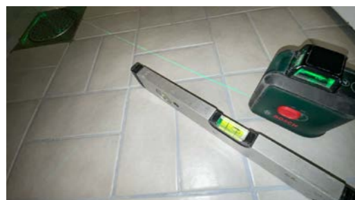
Fallforhold målt i retning sluk.
