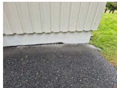
Synlig vorteplast og noe under terreng.
