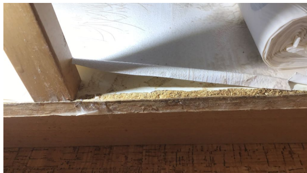
Skader på skap
