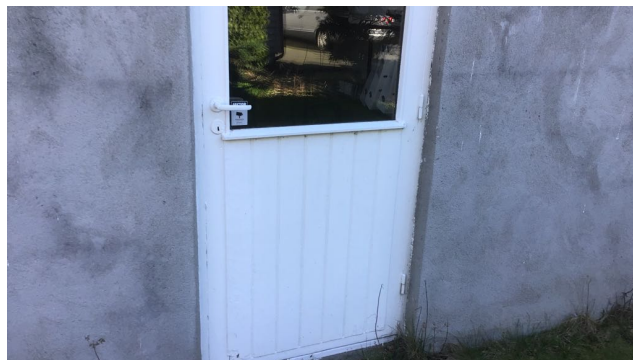
Fukt/råte skader i nedkant kjellerdører
