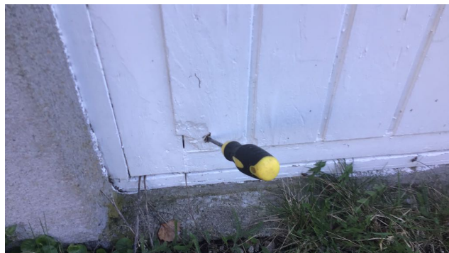
Fukt/råte skader i nedkant kjellerdører
