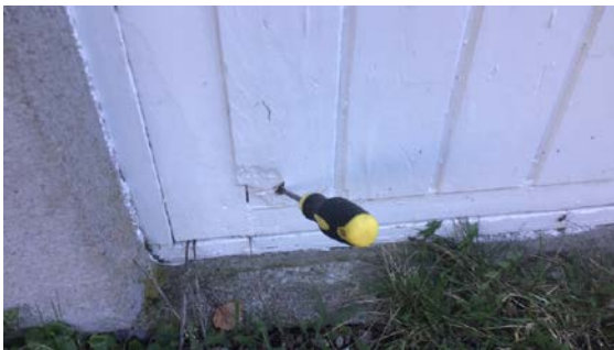
Fukt/råte skader i nedkant kjellerdører
