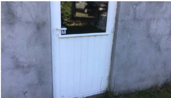
Fukt/råte skader i nedkant kjellerdører
