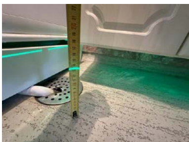
Kontroll av fallforhold.
