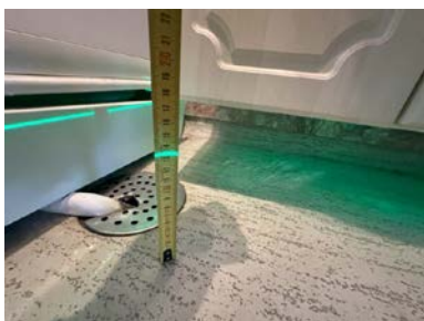
Kontroll av fallforhold.
