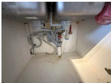
Kontroll av røropplegg.
