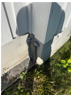
Utvendig lufterør og påfyllingsrør til brenseltank.
