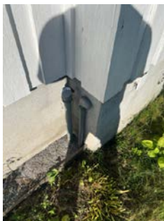
Utvendig lufterør og påfyllingsrør til brenseltank.
