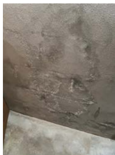
Saltutslag på yttervegg i kjeller
