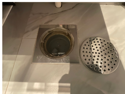
Hjelpesluket under servanten
