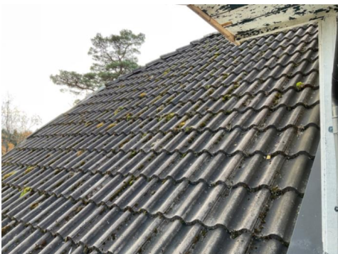
Mose på taktekking.
