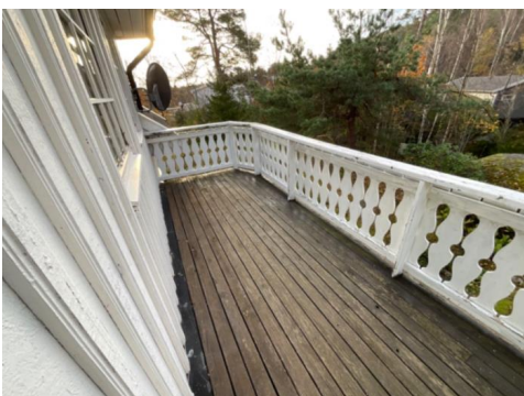
Balkong mot sør.
