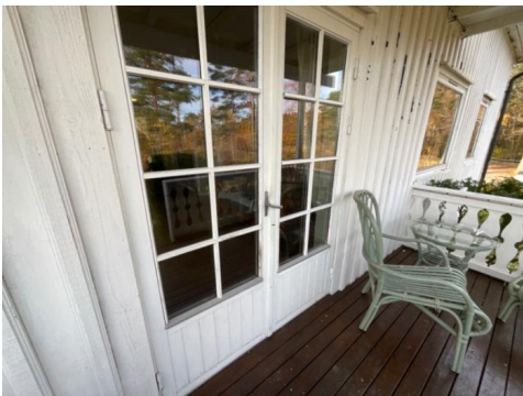
To-fløyet terrassedør i 1. etg.
