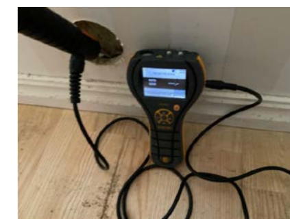
Fuktmåling i vegg
