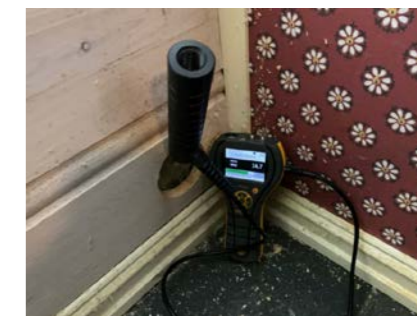
Fuktmåling i utforet vegg.
