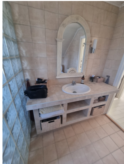
Plassbygget baderomsinnredning med nedfelt servant.
