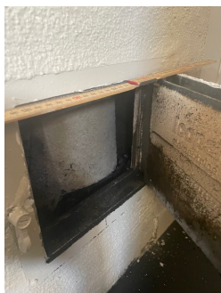
Ildsted mangler ubrennbar plate på gulv
