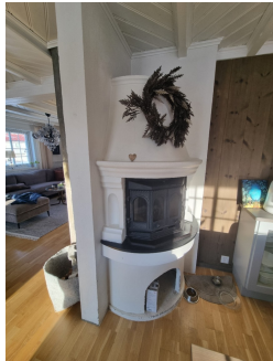
Ildsted mangler ubrennbar plate på gulv
