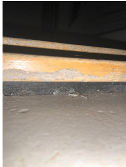
Membran ført oppunder dørterkself
