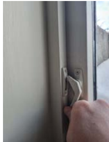
Hasper treffer ikke som de skal på vinduer på soverom i kjelleretasjen.
