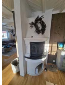
Ildsted mangler ubrennbar plate på gulv
