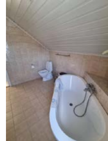
Gulvmontert toalett og badekar.
