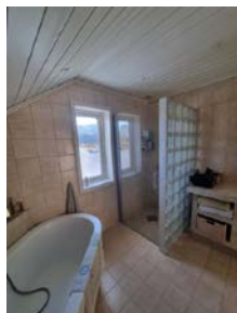
Mekanisk avtrekk og vindusventil.
