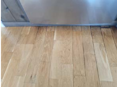
fuktskadet parkettgulv ved kjøleskap og kjøkkeninnredning på kjøkken.
