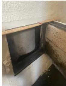
Ildsted mangler ubrennbar plate på gulv
