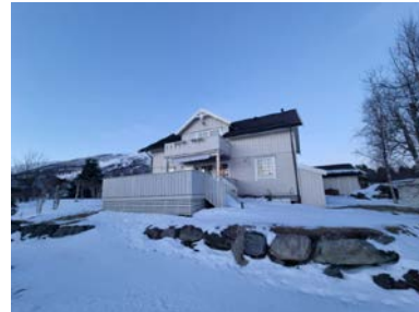
Tretrapp opp til terrasse fra plen
