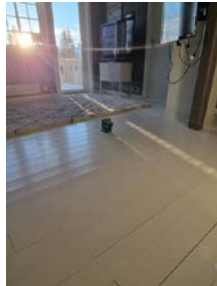
Laser plassert midt i gang i 2. etasje. Det ble målt ca. 20 mm høydeavvik gjennom hele rommet.
