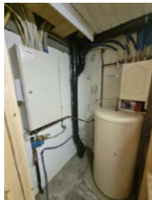
Vannledning fra stoppekran til rør i rør.
