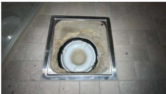
Kontroll av sluk.
