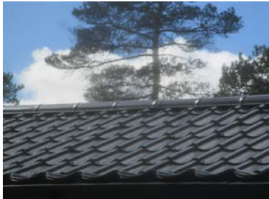
Minimal slitasje på taktekkingen.
