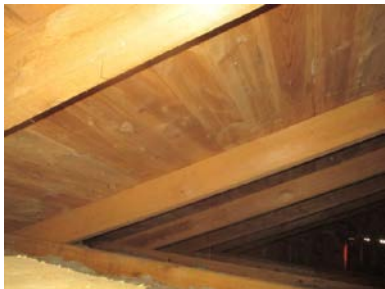
Deler av undertaket.
