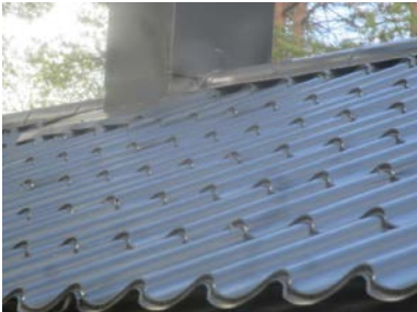
Deler av taktekkingen.
