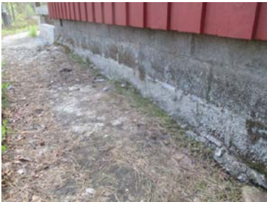
Deler av ringmur av blokker.
