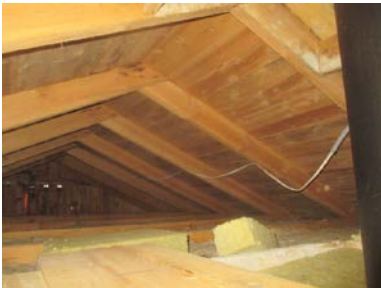
Deler av kaldtloftet. Gavlvegger ikke vindtettet.
