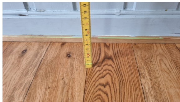
Kontroll av planavvik.
