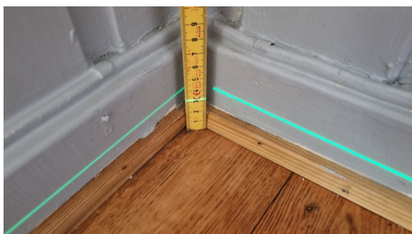
Kontroll av planavvik.
