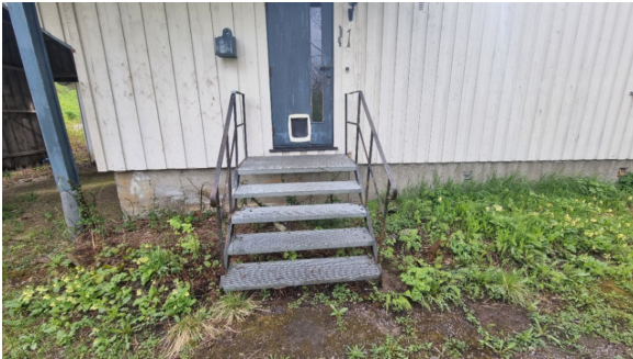
Strekkmalltrapp til inngangsdør.
