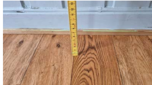
Kontroll av planavvik.
