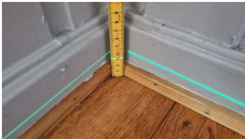
Kontroll av planavvik.
