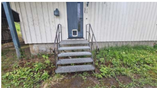
Strekkmalltrapp til inngangsdør.
