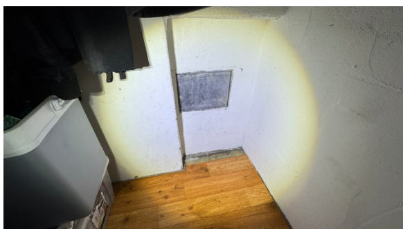
Kontroll av sotluke.
