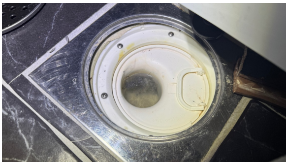
Kontroll av sluk.
