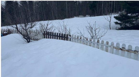
Stakittgjerde har noe værslitasje.
