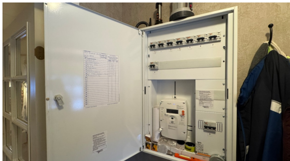
Kontroll av el-skap og kursfortegnelse.
