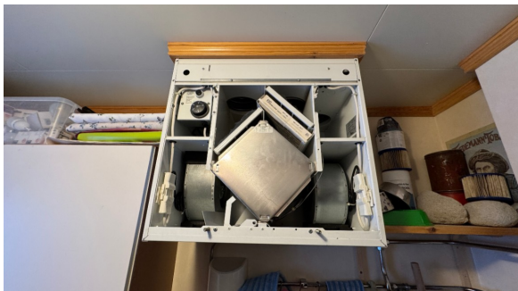
Kontroll av avtrekksventilasjonsanlegg.
