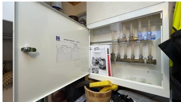
Kontroll av rørfordelerskap.
