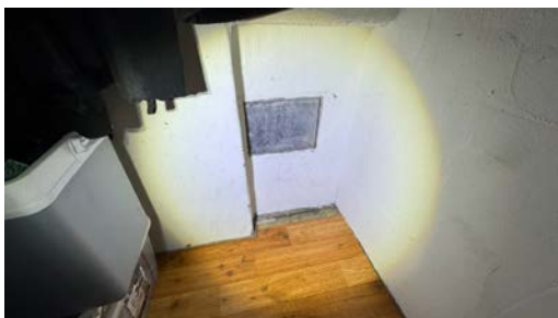
Kontroll av sotluke.
