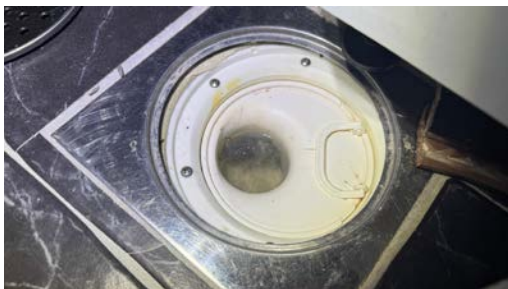
Kontroll av sluk.
