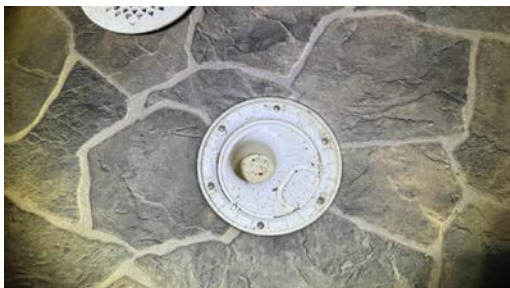
Kontroll av sluk.
