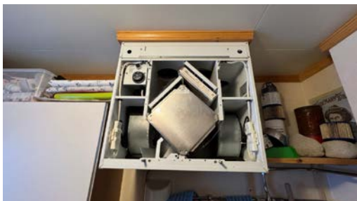
Kontroll av avtrekksventilasjonsanlegg.
